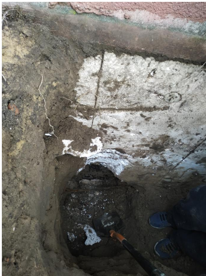
Zdj. nr 3 Wynik odkrywki nr 1 muru fundamentowego zewnętrznego
