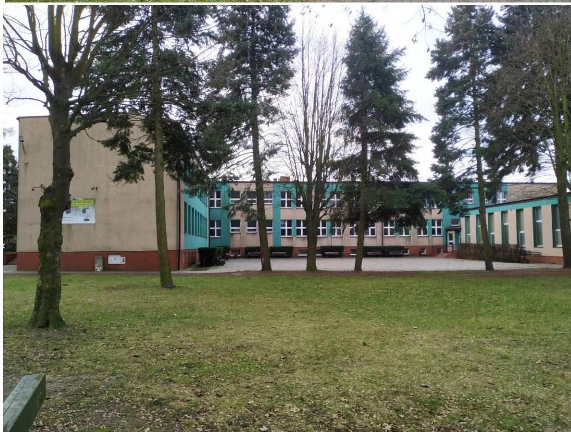
Zdj. nr 1 Widok ogólny budynku Liceum Ogólnokształcącego im. M. Kopernika w Wieruszowie
