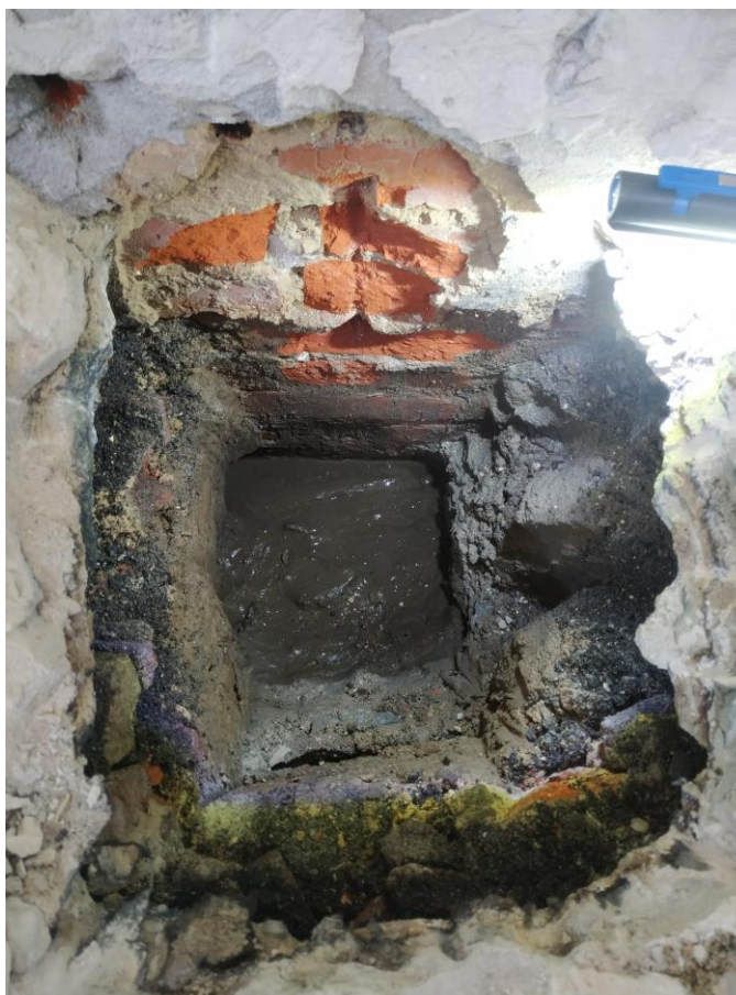
Zdj. nr 4 Wynik odkrywki nr 2 muru fundamentowego wewnętrznego
